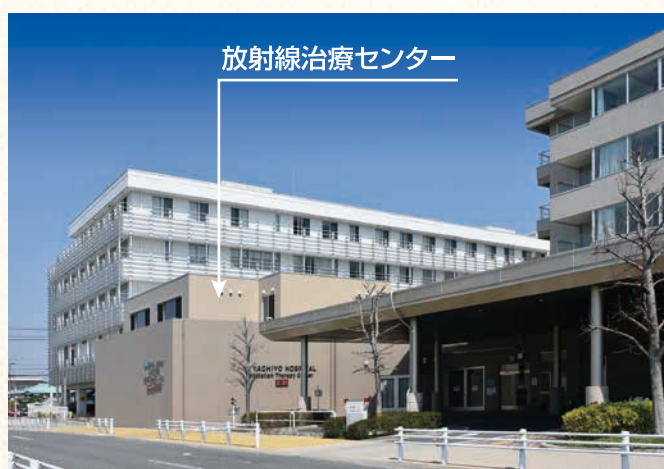
▲救急センターの左手に誕生した「放射線治療センター」の治療棟
